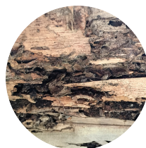
脱衣場の床面の解体が始まったところです。職人さんが乗った瞬間で20cmも床が沈み、非常に危険な状態でした！
