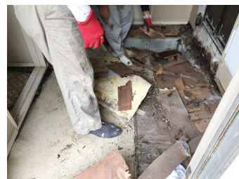
脱衣場の床面の解体が始まったところです。職人さんが乗った瞬間で20cmも床が沈み、非常に危険な状態でした！
