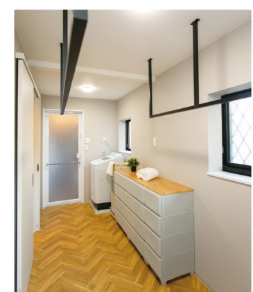
物置同然だった和室をランドリールームに南向きだった和室は床をフローリングに貼り替えて室内干しスペースを確保し、洗濯機を設置。
