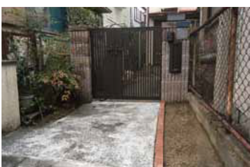
追加でコンクリートベースを敷いたり花壇を直したりと、良い仕上がりになっています！
