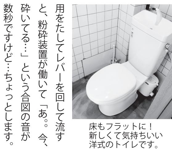
『排水圧送粉碎ポンプ一体型トイレ』これを置いて、後はまるで延長コードを這わすように、細い配管を屋外の污水管に届かせるだけの工事です。
