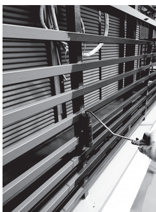
錆止めを塗ってから 仕上げる塗装です。
