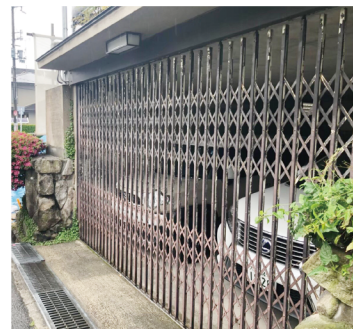
工事前の金属の伸縮門扉
