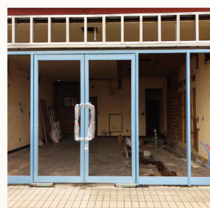
解体後まずは入口のサッシ！
