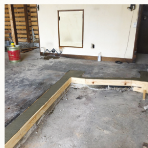
床の段差をなくします。
