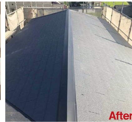
■軽いスレート瓦に葺替え、工事完了！
